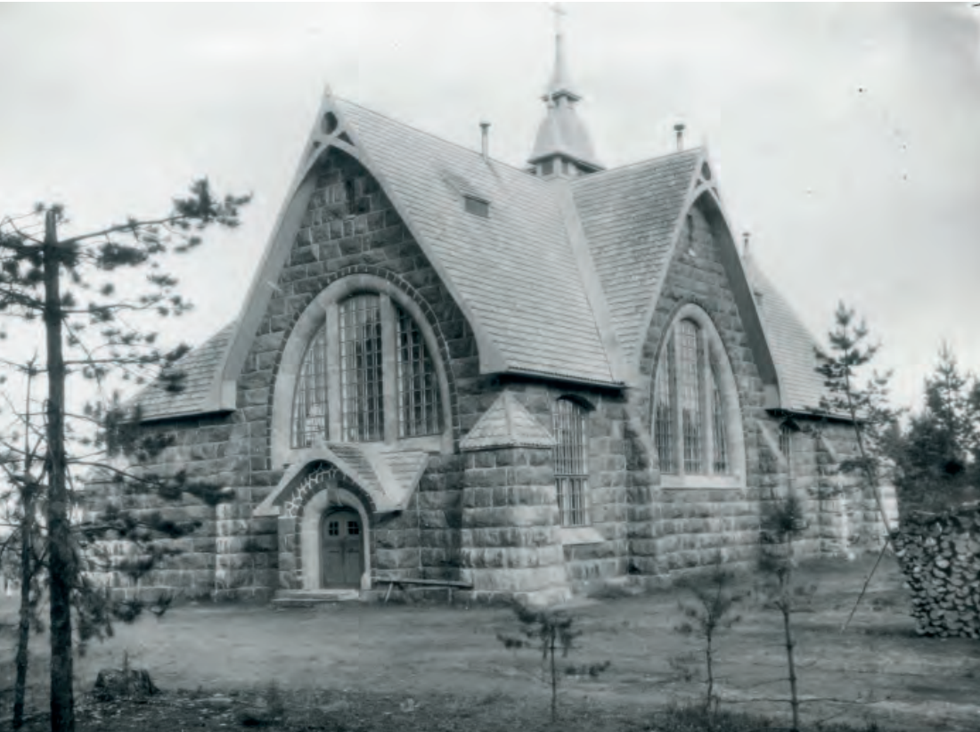
Kirkko luoteesta nähtynä 1900-luvun alkukymmenellä. Museovirasto. Katonharjoilla näkyy kaminalämmityksen savupiippuja, jotka myöhemmin on poistettu. Huom. Etenkin viistoilla kivipinnoilla näkyy sadeveden aiheuttamia, kivien saumaukseen käytetyn laastin kalkkivalumia.
