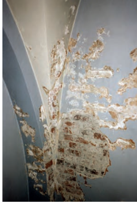
Seinämuureihin pesiytyneen kosteuden aiheuttamia vaurioita kirkkosalin puolella. Kuvat 1990-luvun alusta. Vaurioita oli lisännyt alkuperäisen kalkkimaalin päälle 1930- ja 1960-luvulla maalatut öljy- ja alkydimaalikerrokset, joiden takia kosteus ei päässyt haihtumaan kirkkosaliin päin.
