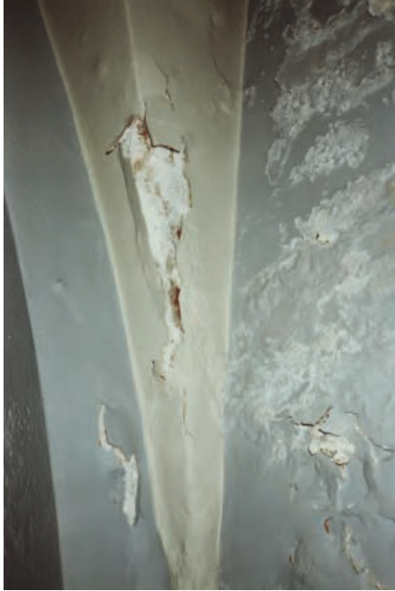
Seinämuureihin pesiytyneen kosteuden aiheuttamia vaurioita kirkkosalin puolella. Kuvat 1990-luvun alusta. Vaurioita oli lisännyt alkuperäisen kalkkimaalin päälle 1930- ja 1960-luvulla maalatut öljy- ja alkydimaalikerrokset, joiden takia kosteus ei päässyt haihtumaan kirkkosaliin päin.
