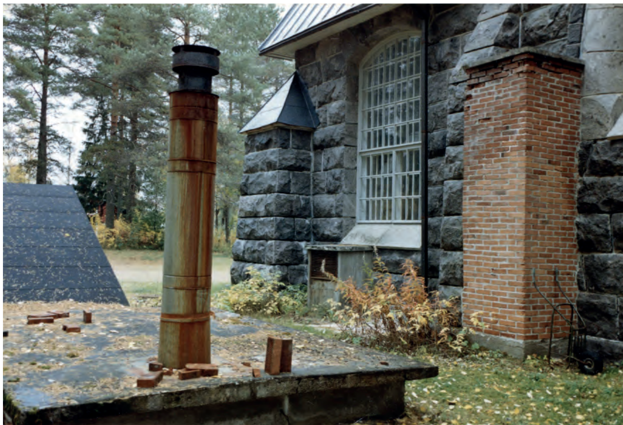
Kirkon länsipuolelle 1960-luvulla tehty lämpökeskus, joka purettiin vuonna 1993. Kuva vuodelta 1992.
